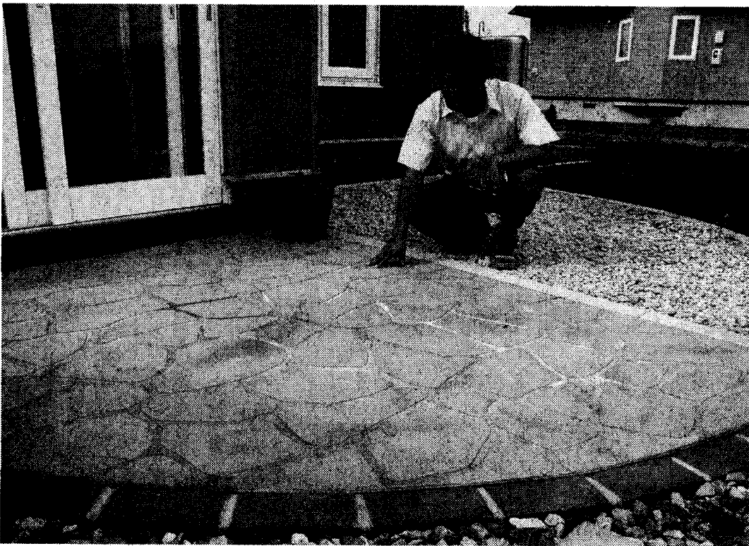
ステンシルコンクリート工法で施工した玄関アプローチ
